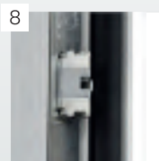
Zasuwnica GU ryglowanie górne
